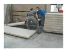
Les plaques sont posées à plat sur un support stable en extérieur, la découpe s'effectue à deux, un qui manipule l'outil et le second qui aide à la manutention des plaques.
